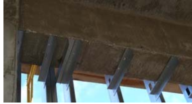
Stud top clip connections
